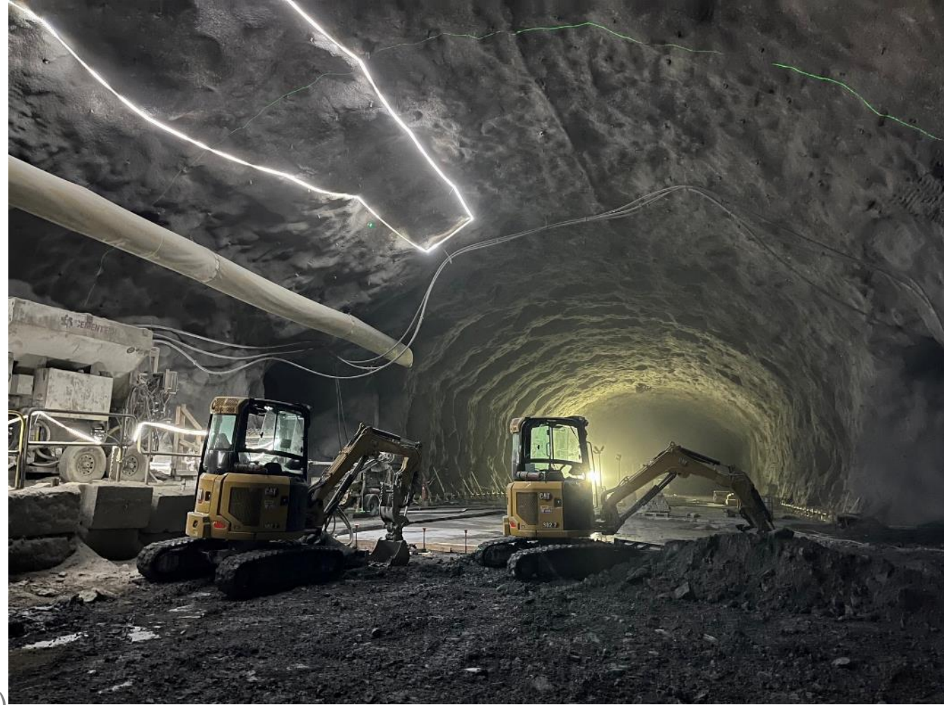
Prepping for mudmat pour - Central Utility Cavern (4850-36)
